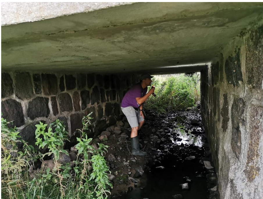
Fot. 24. Kontrola obiektu mostowego.
