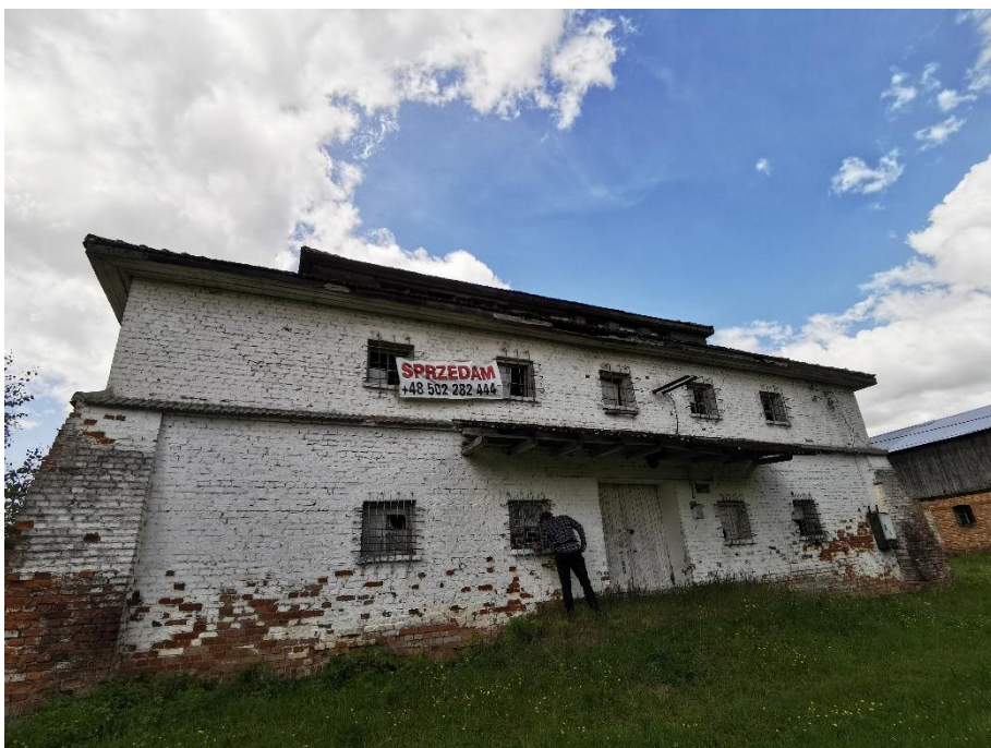
Fot. 27. Kontrola opuszczonego budynku.
